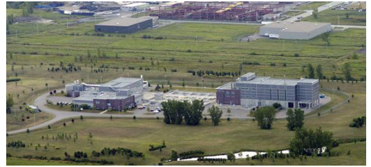
Usine La Pinière de Laval
