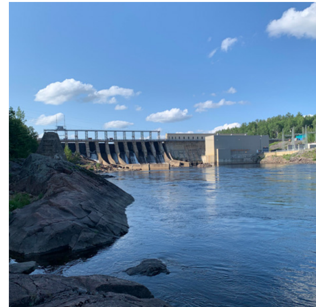
Barrage Mercier du Réservoir Baskatong.
