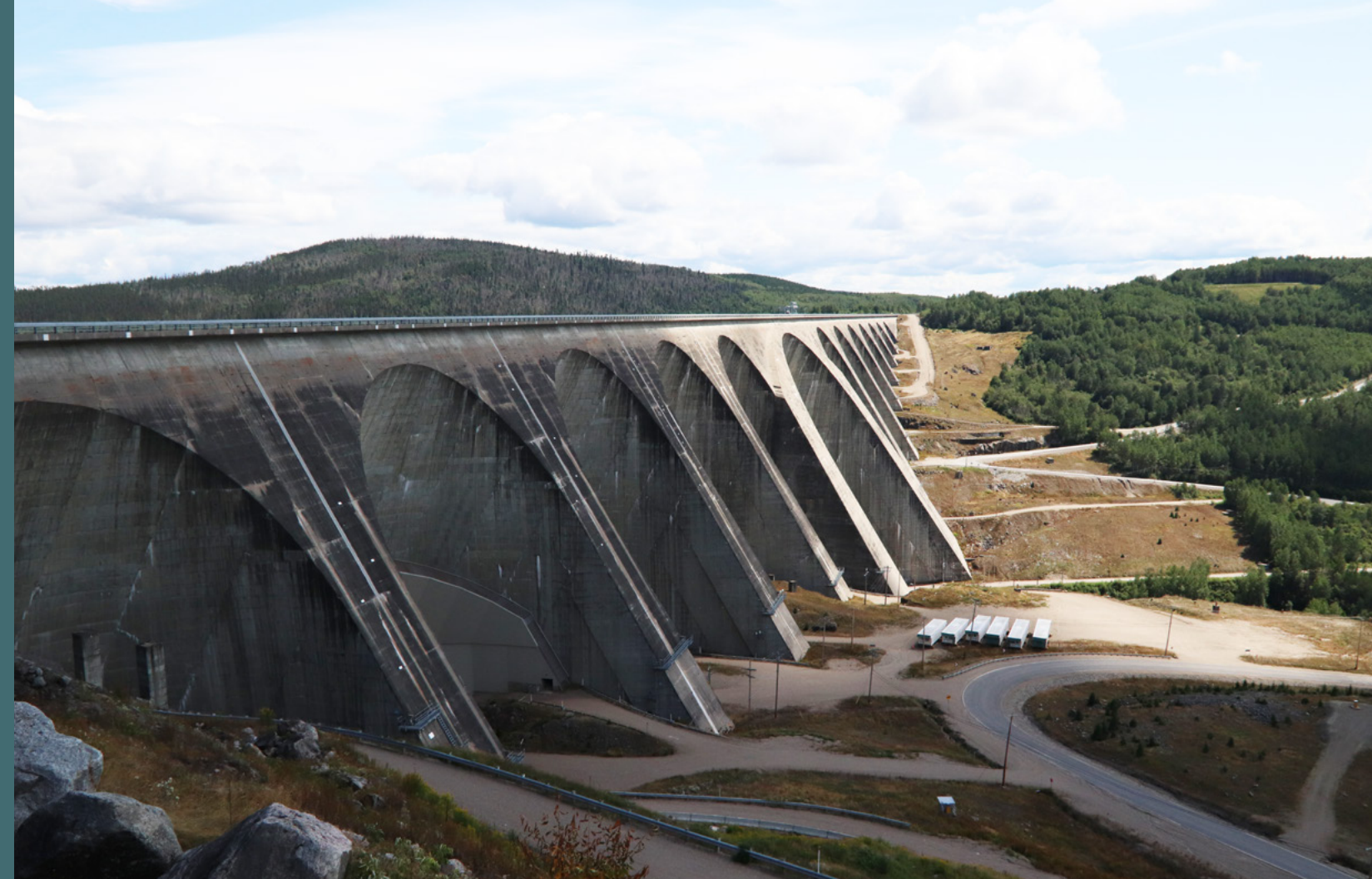
Barrage Daniel-Johnson et la centrale hydroélectrique Manic-5.
